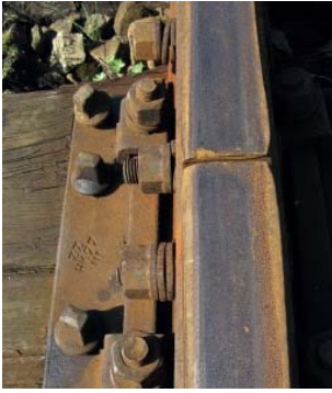
Raylar Arasında Bırakılan Boşluk
