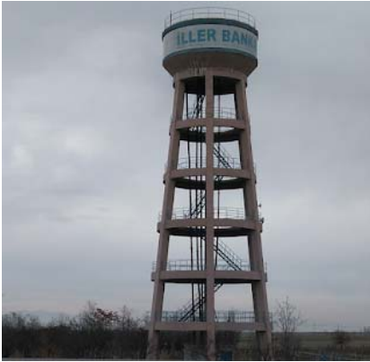
Köylerde kullanılan su deposu
